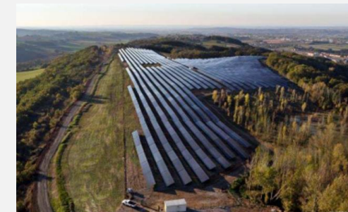
Centrale Solaire du SEQUESTRE Département du Tarn (81) Puissance électrique : 4 500 kWc Mise en service : Octobre 2013
