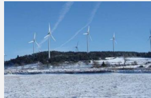
Parc de SAINT JEAN LACHALM Département : Haute-Loire (43) Puissance électrique : 18MW 9 éoliennes Mise en service : 2008
